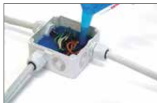
3.- Rellenar la caja Verter el contenido del compuesto sellante hasta cubrir por completo la caja.
