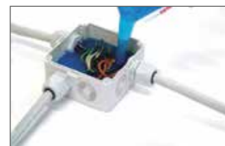
3.- Rellenar la caja Verter el contenido del compuesto sellante hasta cubrir por completo la caja.
