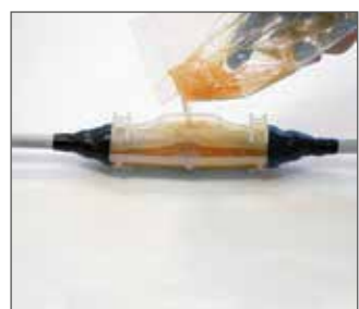
3.- Rellenar torpedo Verter el contenido del compuesto sellante hasta cubrir por completo la entrada del torpedo.
